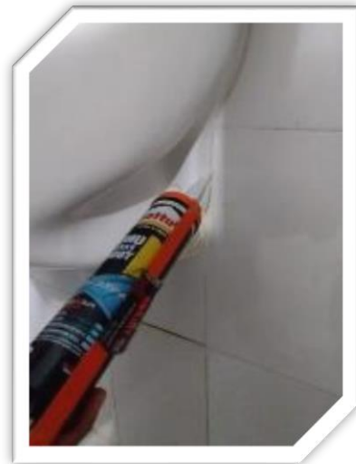
REPARACION DE FUGA MENOR
